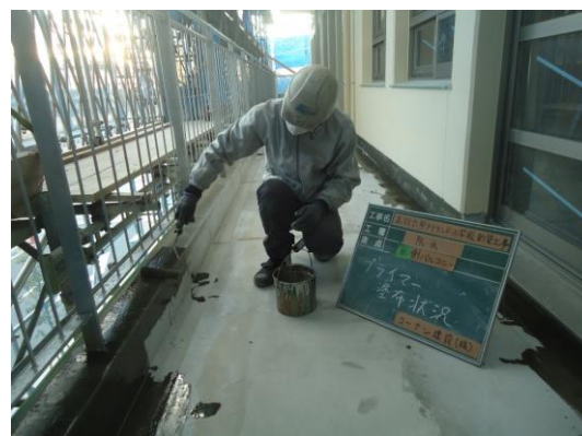
【プライマー塗布】
