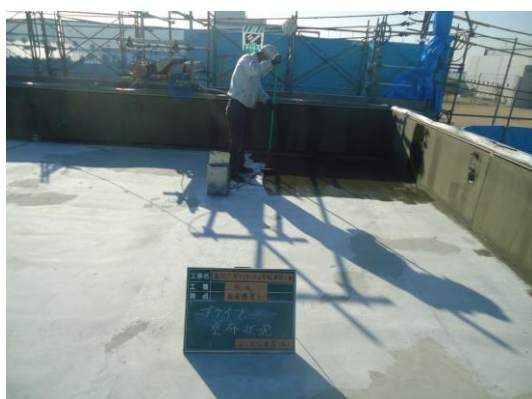
【プライマー塗布】
