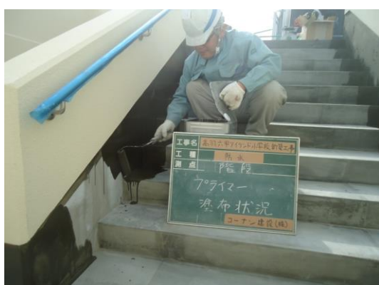
【プライマー塗布】
