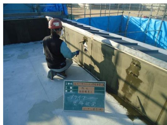
【プライマー塗布】
