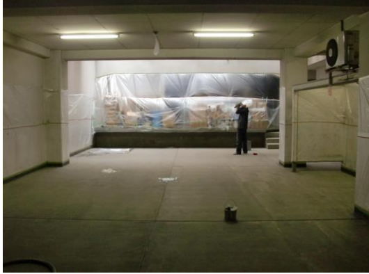
【プライマー塗布 完了】
