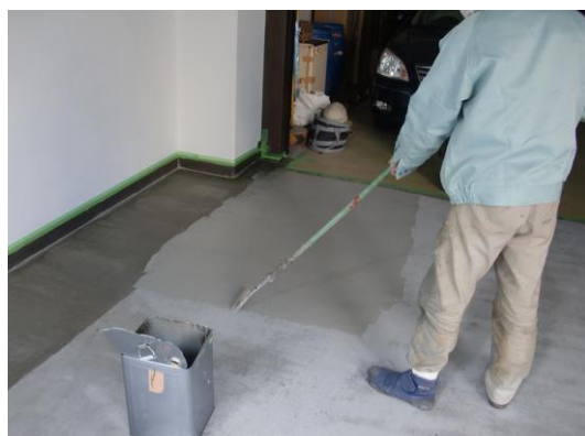
【プライマー塗布】
