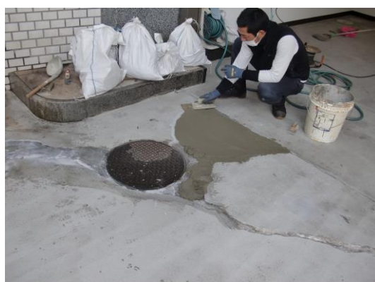
【欠損部補修】
