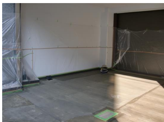
【プライマー塗布完了】
