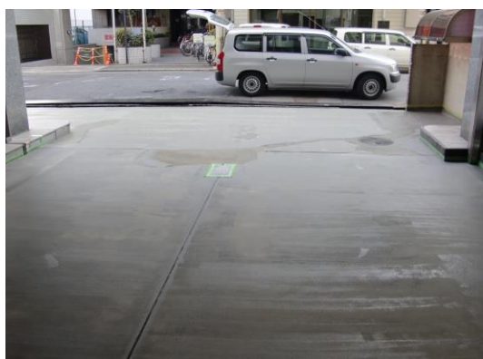
【プライマー塗布完了】
