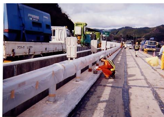
【プライマー塗布】
