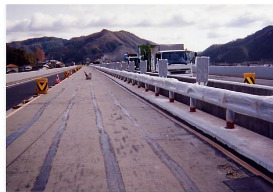
【プライマー塗布 完了】
