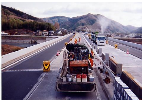
【プライマー塗布 完了】
