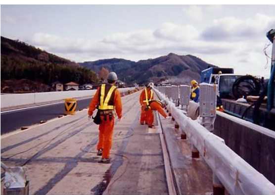
【プライマー塗布】
